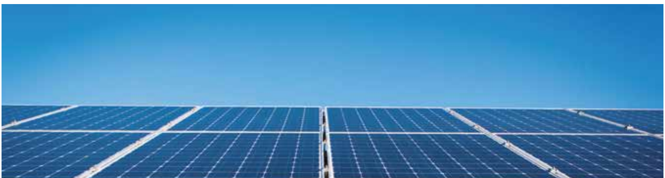
Figura 3 Instalação com parafusos dos módulos monofaciais
